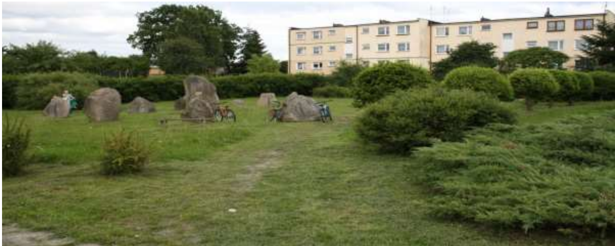
Fot. 2. Zdegradowane ogrodzenie i ochronne słupki Zespołu Szkół w Ostrowcu
