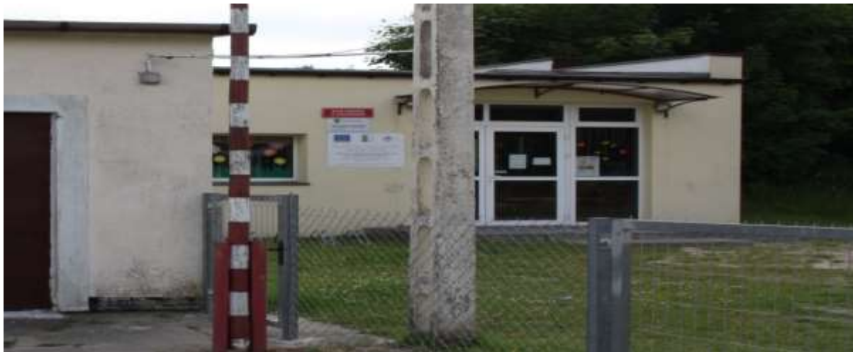
Fot. 6. Nieczynny z powodu zagrożenia zawaleniem budynek z przeznaczeniem na funkcje społeczno-integracyjne
