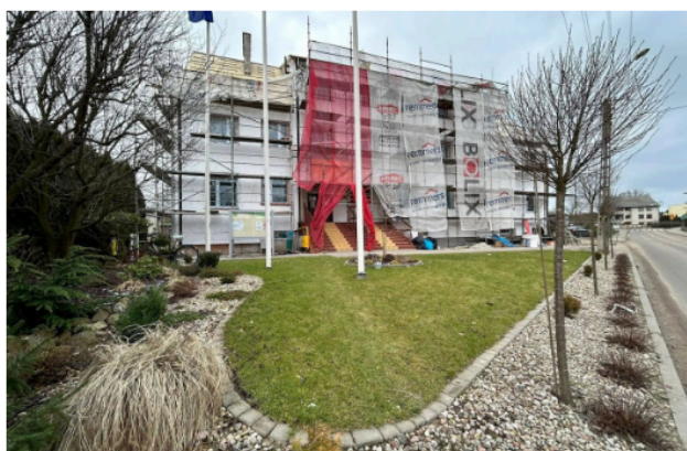
Urząd Gminy - w trakcie termomodernizacji
