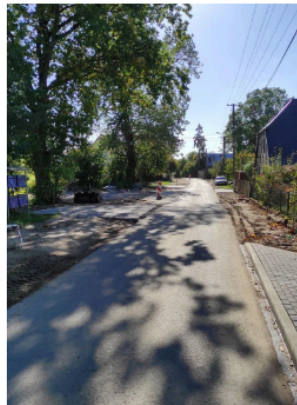
Wyremontowana droga w Gorzycy
