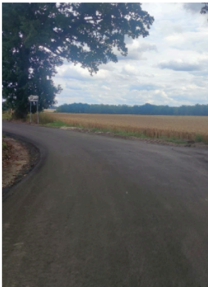
Remont drogi Podgórki - Ostrowiec
