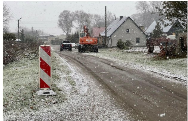
Modernizacja drogi wewnętrznej w Sulechowie
