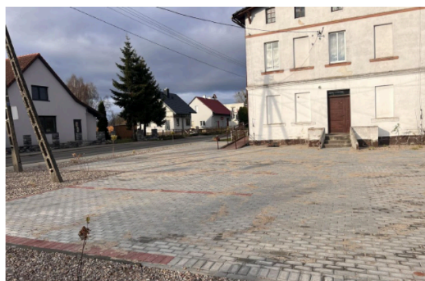
Zmodernizowany parking przy ośrodku zdrowia w Ostrowcu
