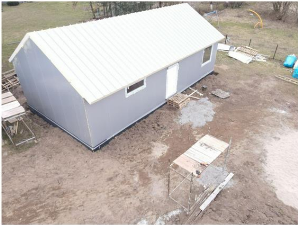
Budynek w Sulechówku
