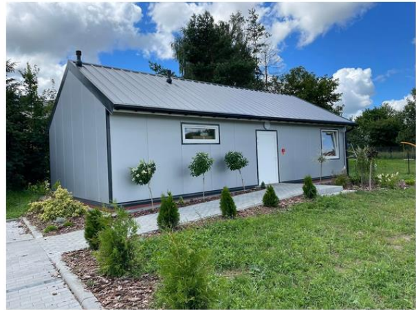
Budynek w Sulechówku
