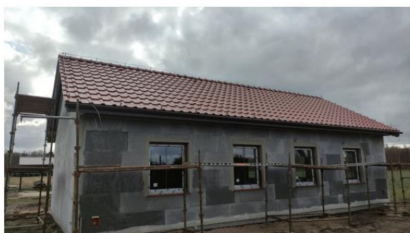
Budynek w Borkowie
