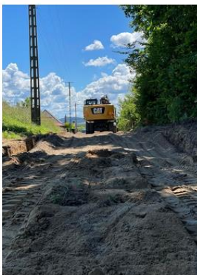
Nowa droga w Gorzycy - w trakcie realizacji
