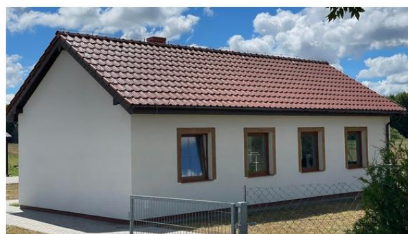
Budynek w Borkowie
