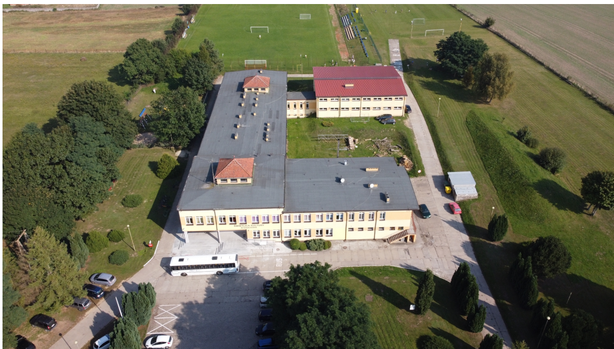
ZSP w Malechowie, Świetlica Kultury oraz tereny rekreacyjno-sportowe. Źródło: UG Malechowo.
