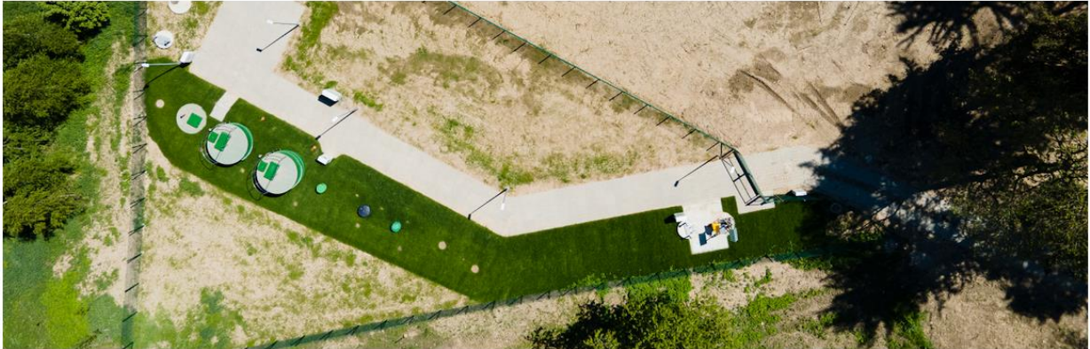
Oczyszczalnia ścieków w Podgórkach
