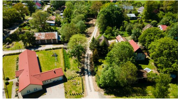
Modernizacja drogi w Gorzycy
