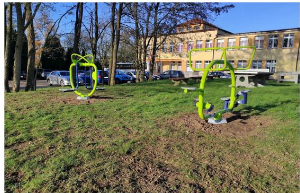
Budowa parku rekreacyjnego w Malechowie
