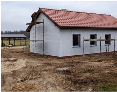
Budowa budynków funkcyjnych
