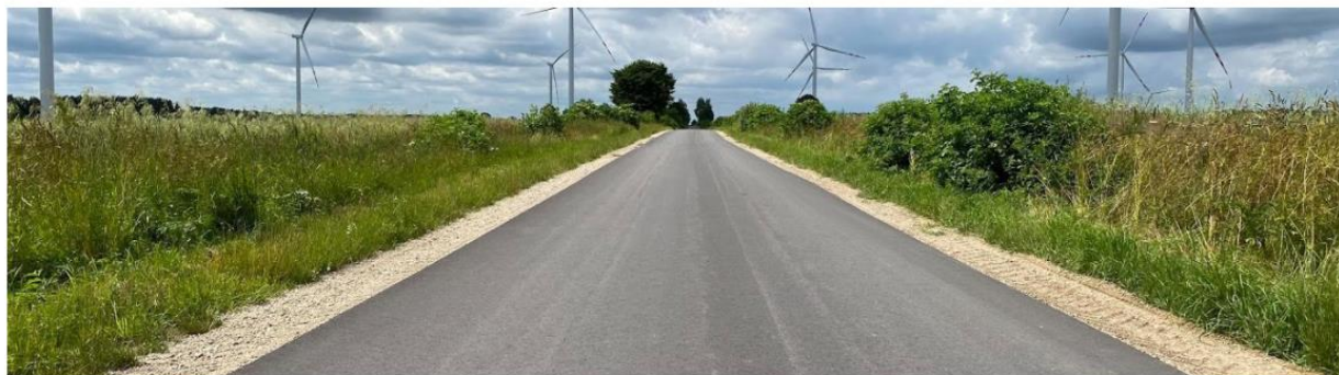
Modernizacja drogi Sulechówko-Witosław
