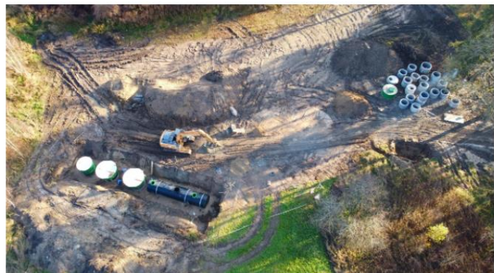
Budowa oczyszczalni ścieków w Podgórkach
