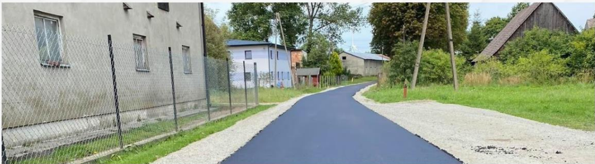
Wyremontowana droga w Darskowie
