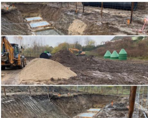
Budowa oczyszczalni ścieków w Podgórkach
