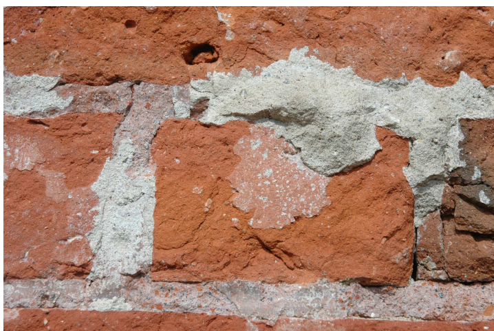
Fot. 10 Zachowana szlichta wapienna z pyłem cementowym
