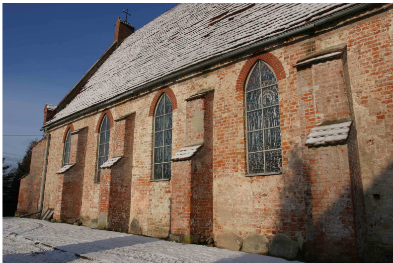
Fot.2 Elewacja południowa po skuciu tynku
