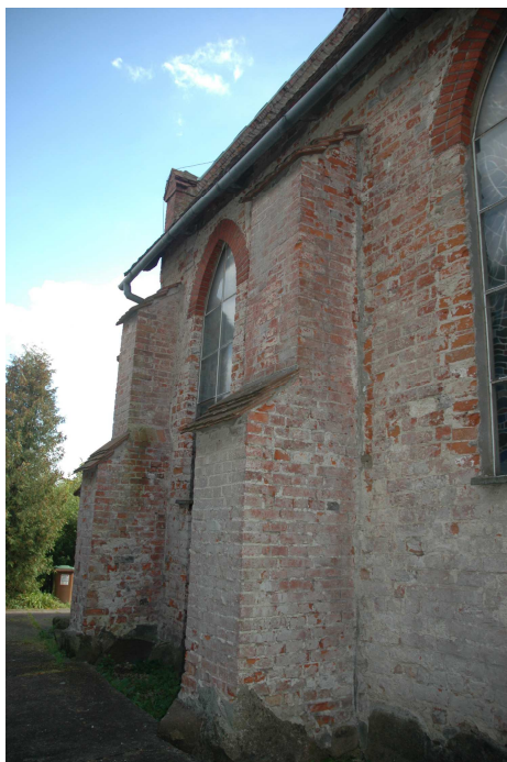
Fot.5 Fragment elewacji północnej po skuciu tynku
