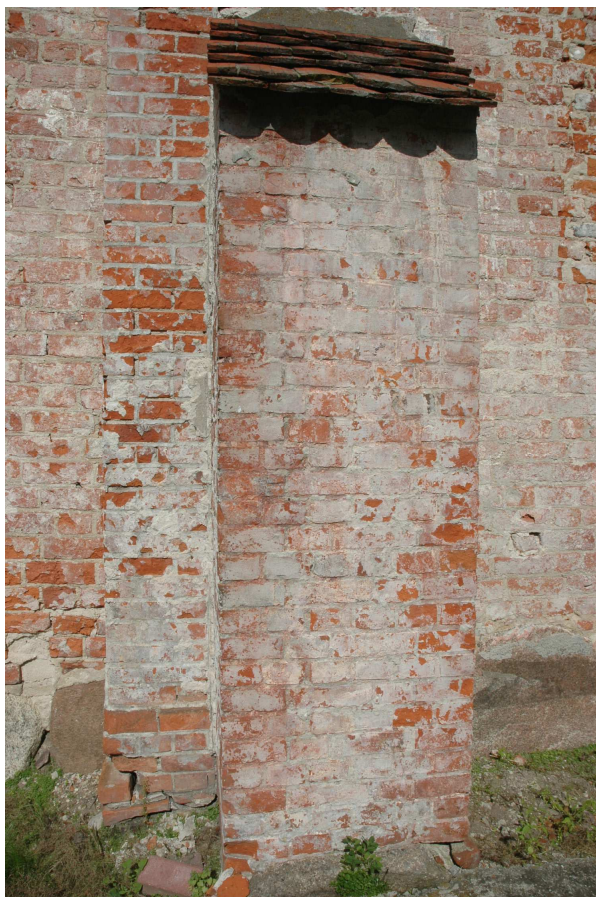
Fot.11 Zbliżenie na elewację południową po skuciu tynku
