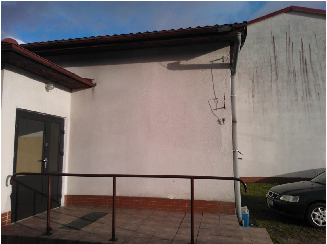
Fot. 1 Ściana wschodnia pomieszczenia nr 44 – spękania narożnika.
